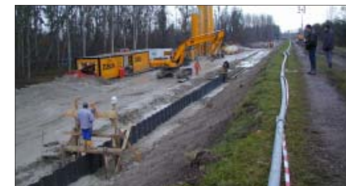
Errichtung einer Dichtwand am Hochwasserdamm
